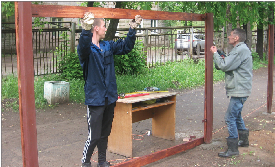
Монтаж нового забора
