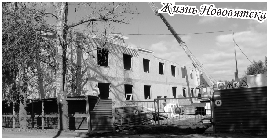
Строительство дома на улице Рухлядьева 16Б
